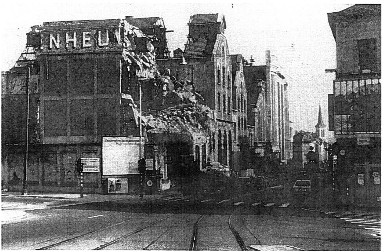
Démolition de la Brasserie Vandenneuvel, à Molenbeek, en 1987.
