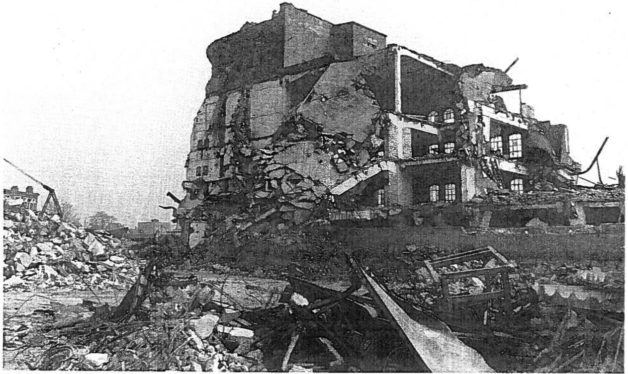
Démolition de la Brasserie Bavaro-Belge, à Anderlecht, en 1984.
