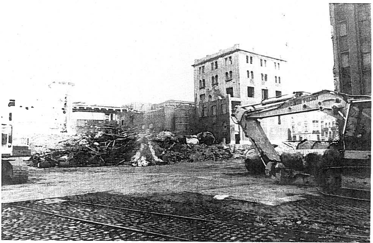
Démolition de la touraille, de l'ancienne chaudière à charbon et de la cheminée en mars 1990.
